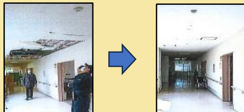
【介護施設の復旧の様子】
