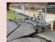
水道の復旧 (被災した浄水場)
