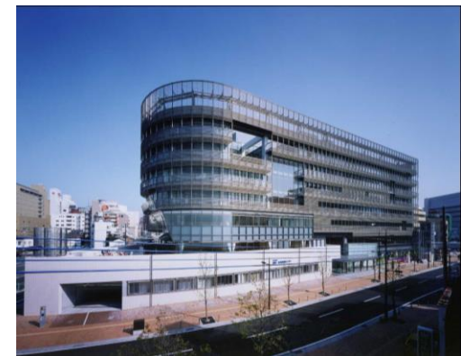
北九州市総合保健福祉センター全景
