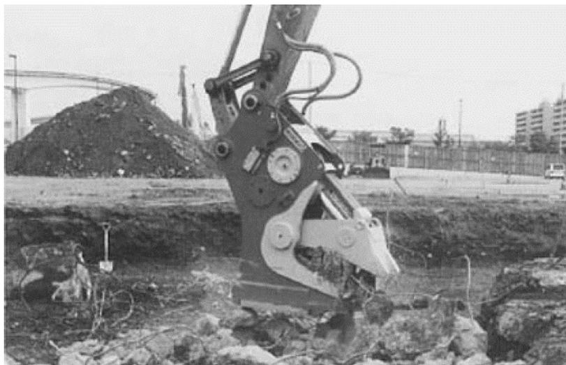
Figura 4-4 Demolición de piezas de concreto pequeñas
