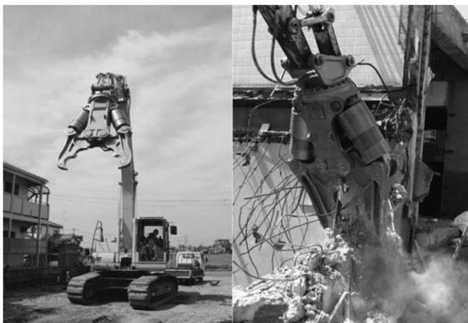
Figura 1-3 Trituradora de concreto
