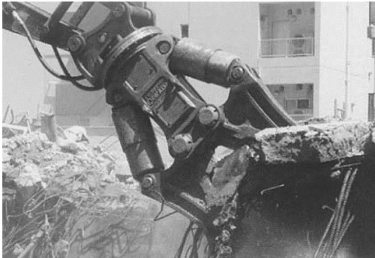
Figura 4-3 Demolición de grandes secciones de estructuras y edificios de concreto
