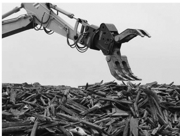
Foto 4-7 Status de processamento de entulhos
