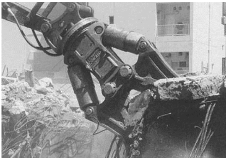
Foto 4-3 Demolição através de britagem de estruturas e edifícios de concreto em pedaços grandes
