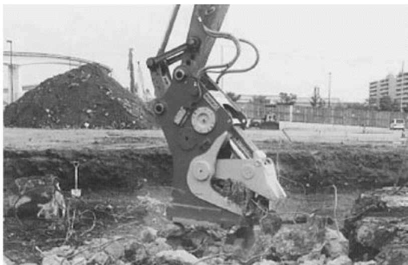
Foto 4-4 Situação de demolição de pequenos pedaços de concreto
