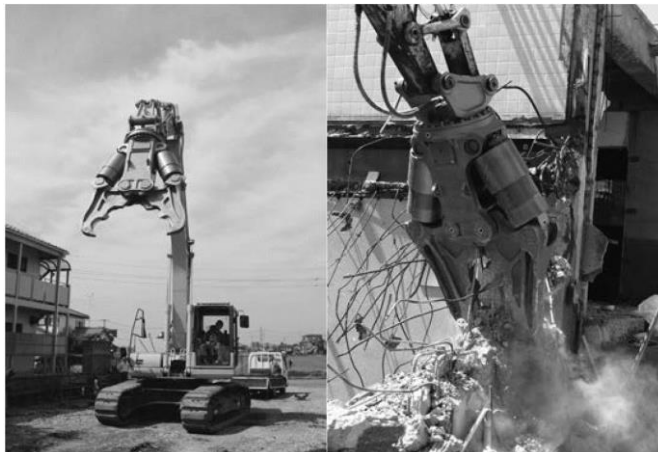
Foto 1-3 Triturador de concreto
