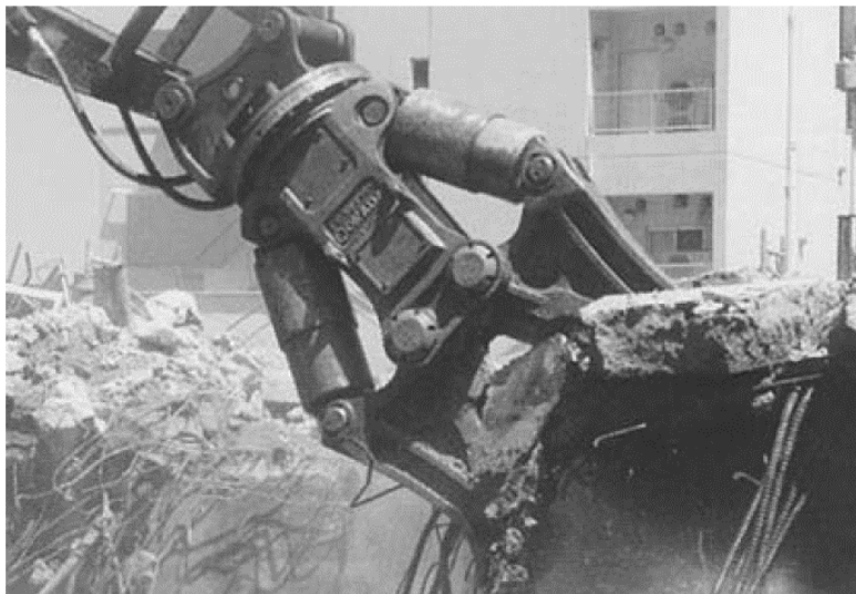
ဓာတ်ပုံ 4-3 ကွန်ကရစ်ဖြင့်ဆောက်လုပ်ဖွဲ့စည်းထားသည့်အရာများ / အဆောက်အအုံအကြီးစားများကိုဖြိုဖျက်မှုအခြေအနေ
