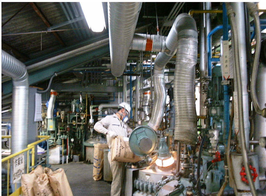
写真－1：実際の測定場所（工場建屋2F：臭気が集中する箇所）
