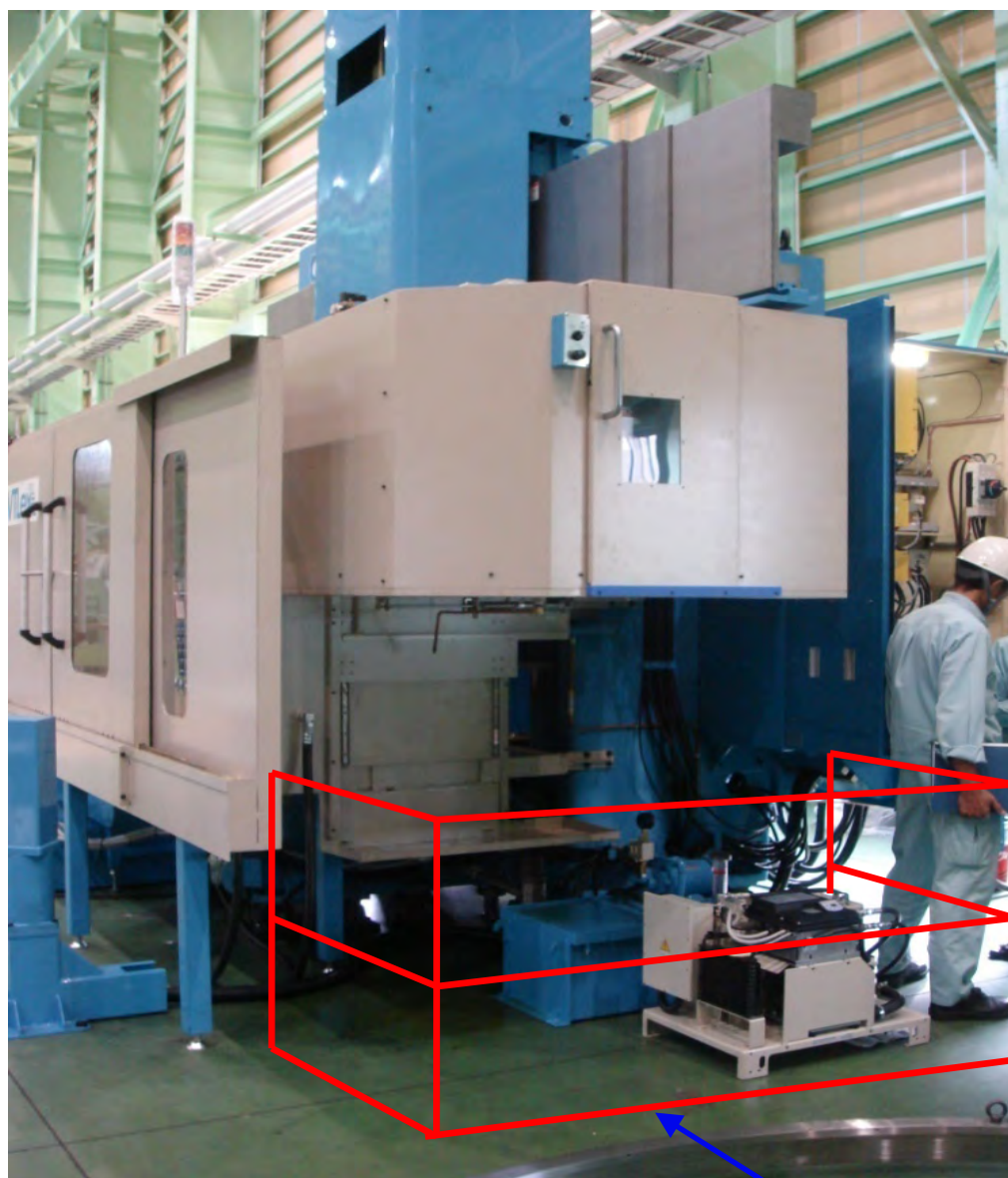
安全柵の設置
