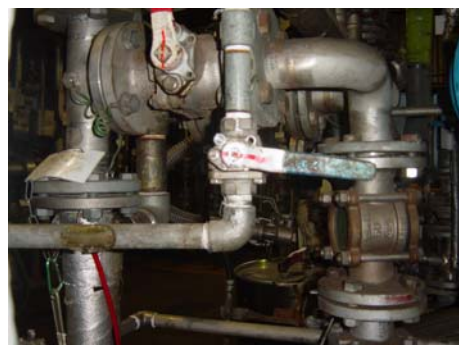
写真 8 DMF 流量調整バルブ 改善後／バルブ開度制限あり
