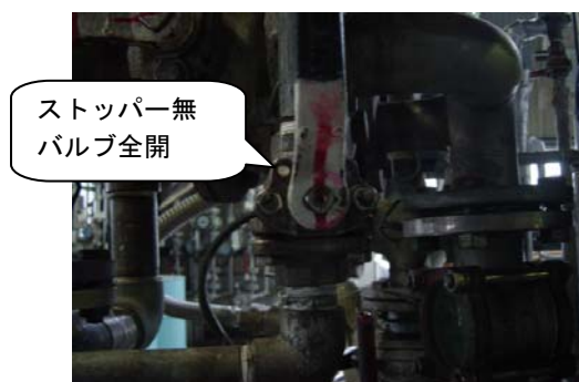
写真 7 DMF 流量調整バルブ 改善前／バルブ全開
