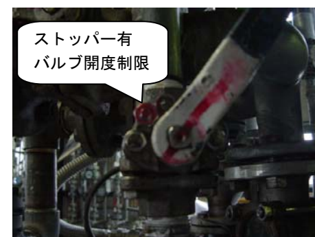
写真 8 DMF 流量調整バルブ 改善後／バルブ開度制限あり
