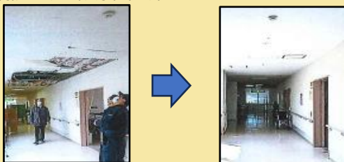
【介護施設の復旧の様子】
