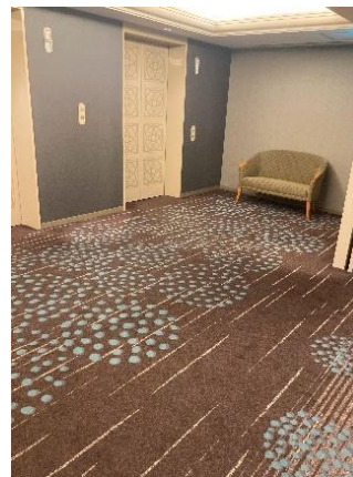
〔カーペット施工 竣工〕
