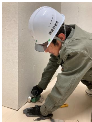
〔長尺シート貼り 圧着作業〕
