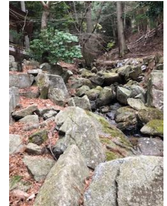
〔流れ石積み技法を用いた、小河川の改修事業〕
