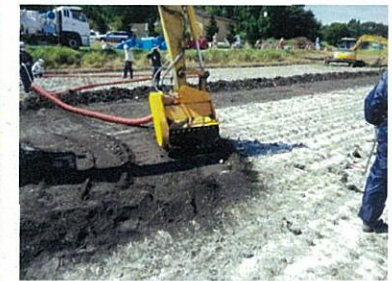
写真4: 改良したバケット部
