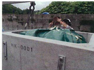
写真2：フレコンバッグ挿入後の状況
