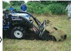
フロントローダを用い、すくい上げによる搬出する。
