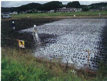
写真1: 固化剤吹き付け作業
