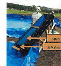
図 4：除染フィルターによる実証試験
