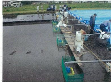
写真2：沈砂地への濁水の排出
