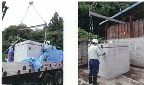
写真1：コンクリート製容器の設置
