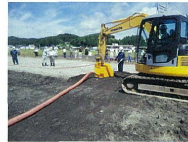
写真3: 表層土の削り取り
