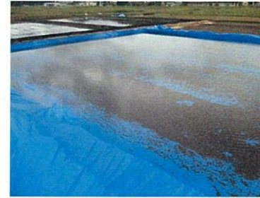
写真3：沈砂地における固液分離
