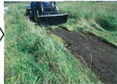
フロントローダを用い、引き剥ぎによる搬出する。
