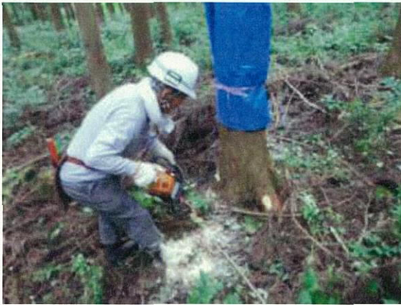
写真4 伐採時の汚染防止のための養生
