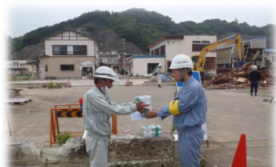
がれき処理現場での防じんマスクの配布の様子
