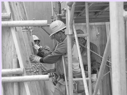
型枠組立訓練
