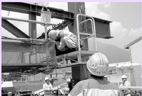
富士教育訓練センター 鉄骨建て方実技講習
