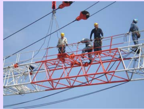
タワークレーンの組立て
