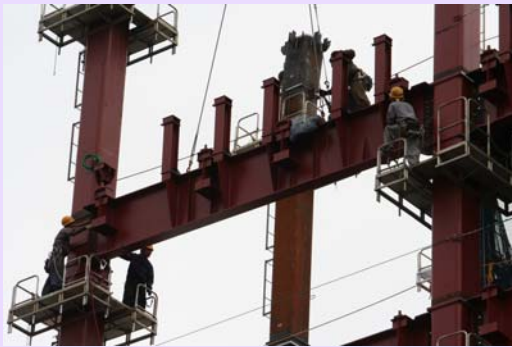
鉄骨建方風景
