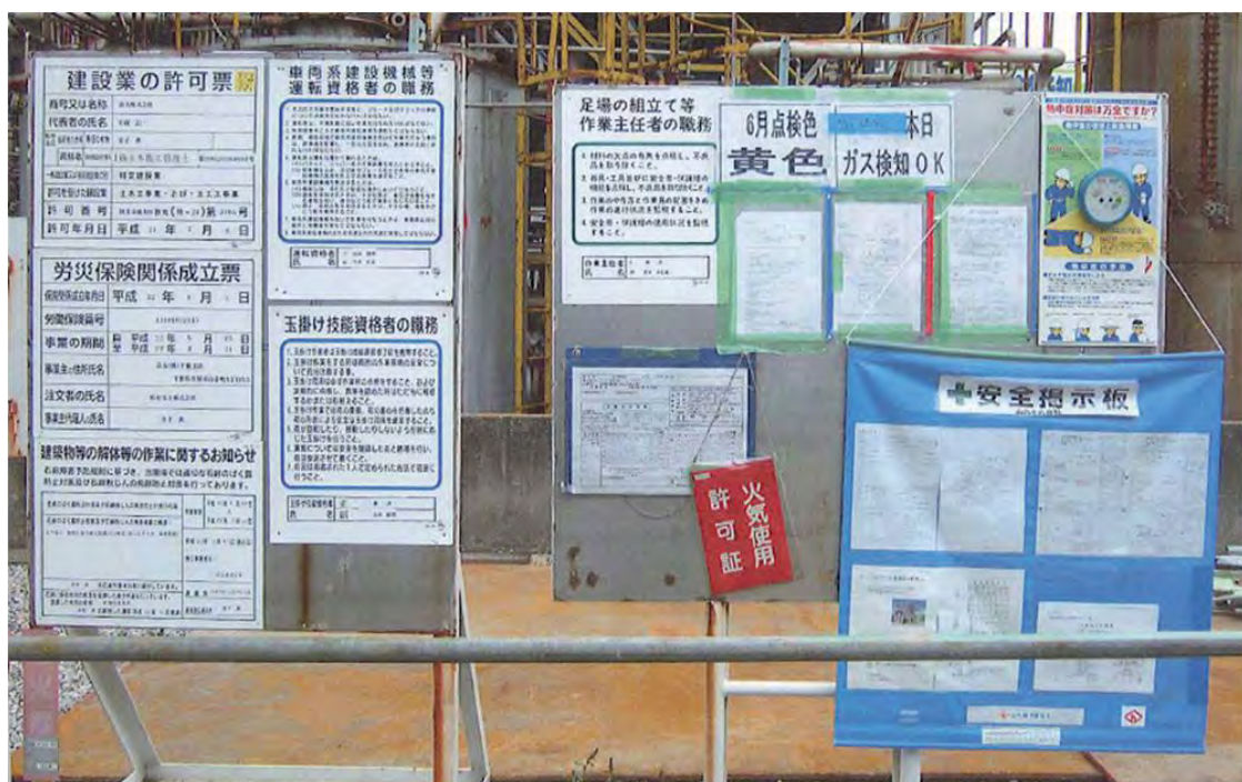
図6. 11 工事・作業の安全掲示板等の事例
