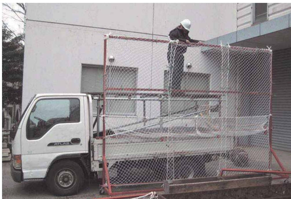
図 3-14 墜落防止柵を荷の横に取り付けた状態
