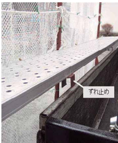
図 3-9 作業床のずれ止めをあおりにはめようとしている状態
