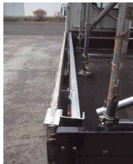
図3-2 簡易作業床を荷台上に収納した状態
