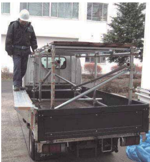
図3-1 簡易作業床をあおりに取り付け歩行している様子
