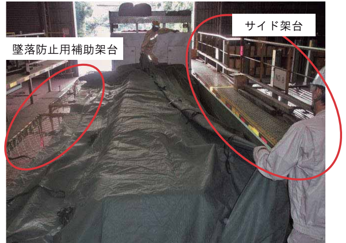
図 4-22 シート掛け作業風景
