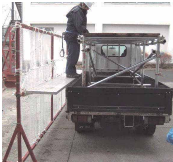
図 3-10 あおりに取り付けた据置型作業床の上を作業員が移動している様子
