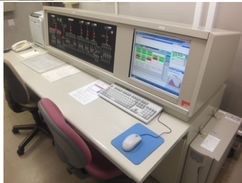
中央監視装置改修
