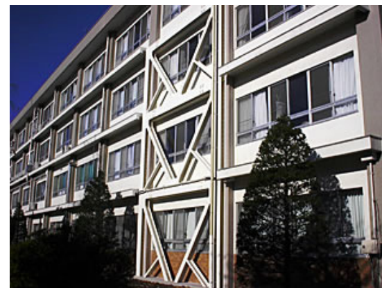
(耐震整備の例)
