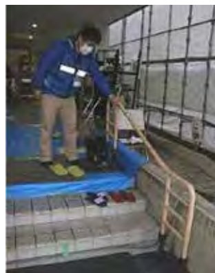
写真⑥ 手すりの設置
