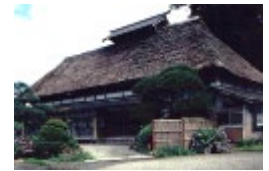
伝統木造住宅
