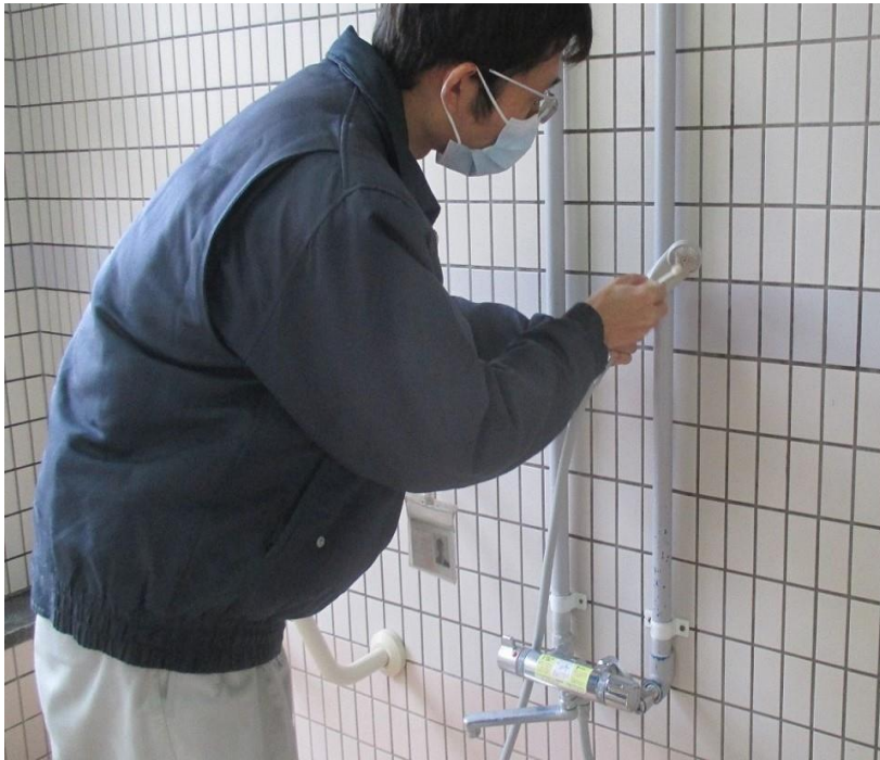
一般浴槽室のシャワーヘッド
