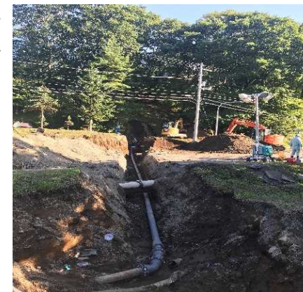
厚真町 新町浄水場導水管補修
