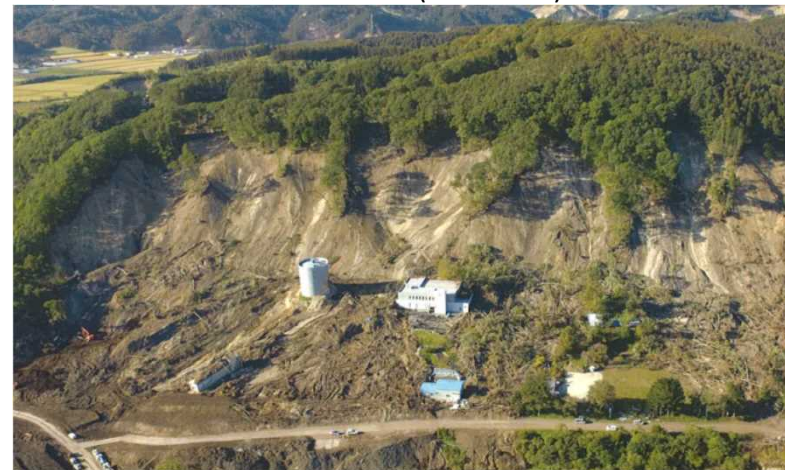
厚真町 富里浄水場・配水池 (土砂崩れ)
