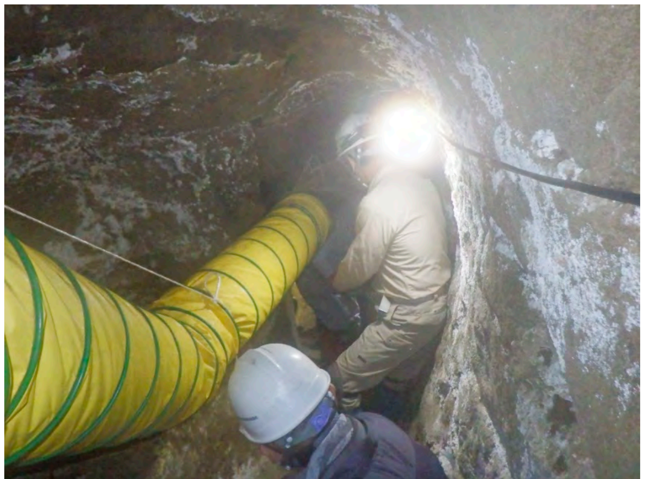
地下塚内部での作業 熱気を地表に逃がすためのパイプを通して (熱気を逃がさないと高温で作業が出来ない)
