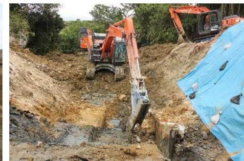
令和元年度糸満市東里の山城壕での遺骨収集の様子 (埋没した構築壕の位置を特定中)
