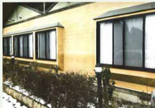
店舗の各窓に網戸設置した後の様子
