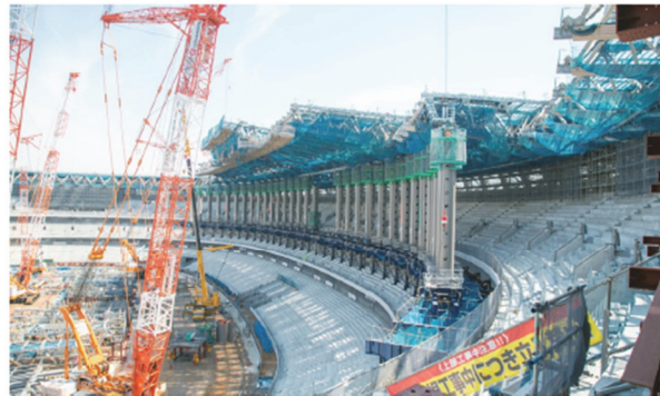
タワークレーン支柱を使用した仮設支保工
