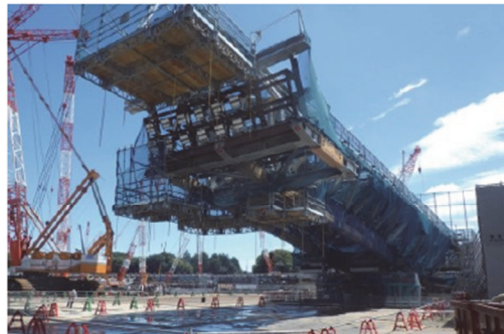
実物大モックアップを地上にて組立、作業手順を確認
